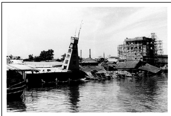
写真4 信濃川 魚市場付近の被害状況
