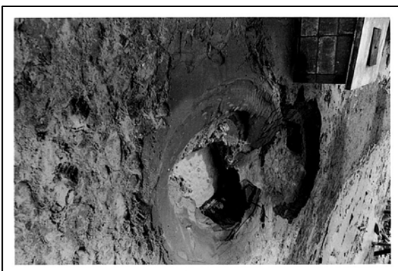
写真3 泥水が噴き上がった後(噴砂)
