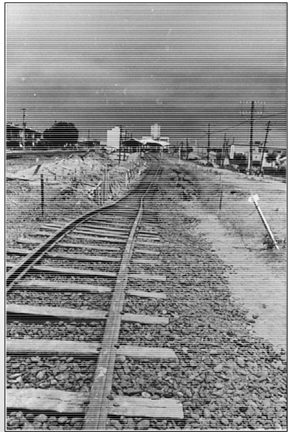
液状化現象によって傾いた県営住宅(左)と曲がったレール(右)
