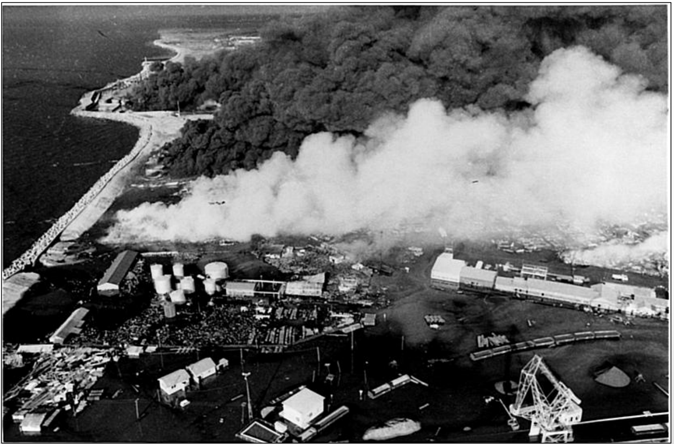
石油タンク火災 黒煙が立ち上る様子
