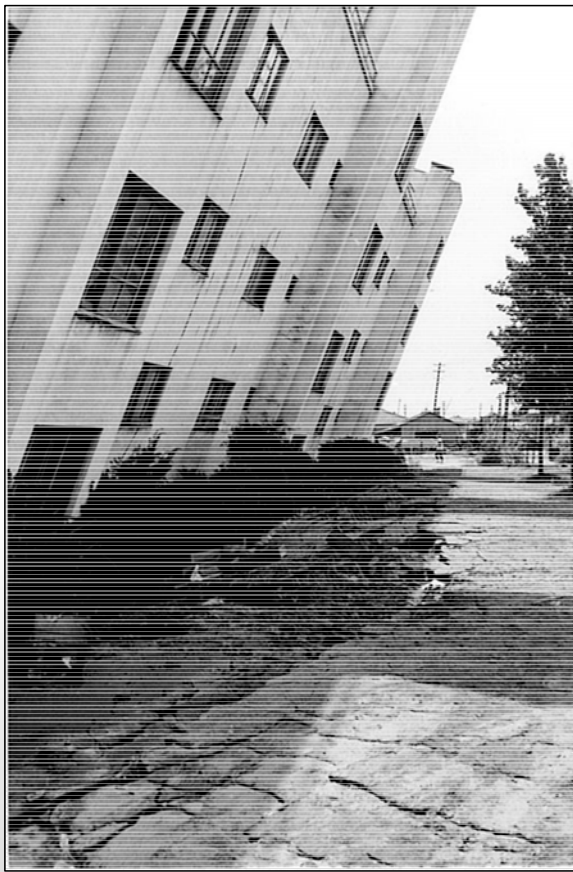
液状化現象によって傾いた県営住宅(左)と曲がったレール(右)
