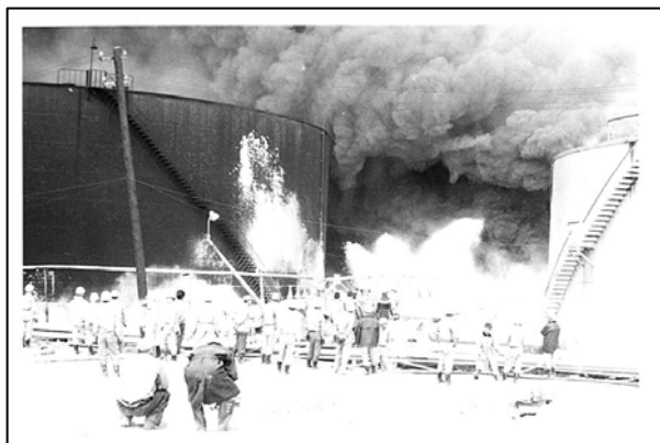
写真6 石油タンク火災
