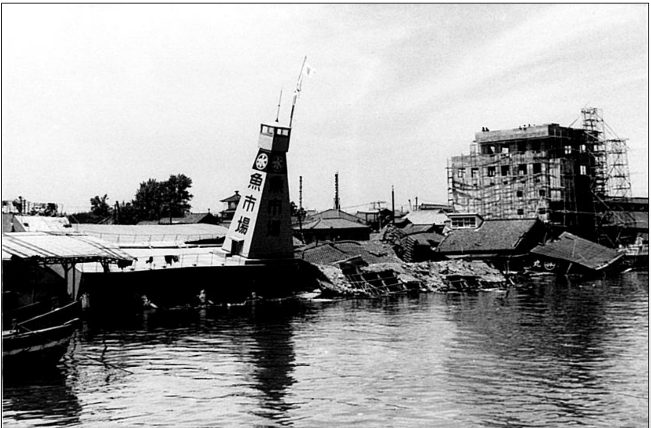
信濃川 魚市場付近の被害状況
