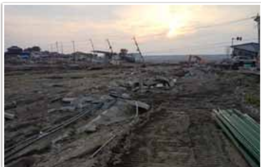
常総市三坂町の決壊現場付近②
