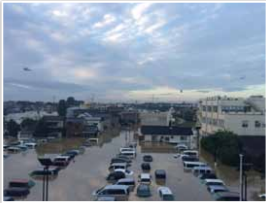
常総市庁舎の駐車場の浸水状況
