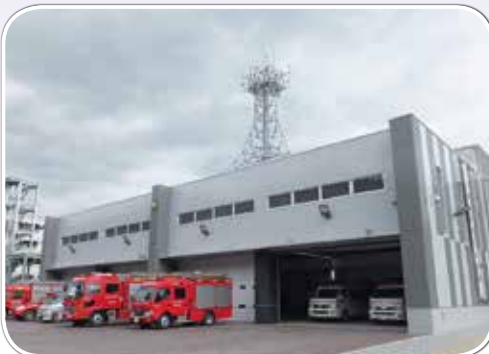
新築された大槌消防署3月19日落成 (岩手県宮古地区広域消防本部)
