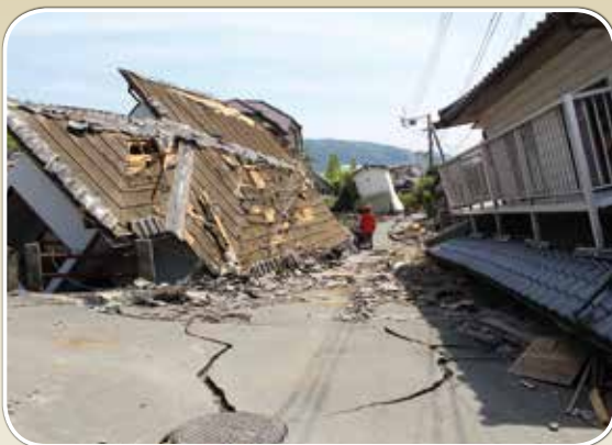
益城町の被害状況(熊本市消防局提供)
