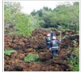
土砂崩れ現場での活動 （南阿蘇村消防団）
