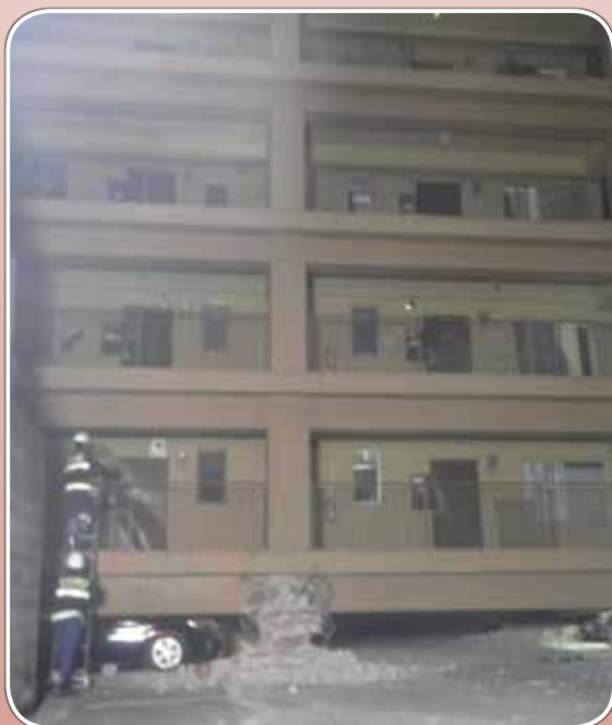
熊本市 座屈マンション救助活動 (熊本市消防局提供)
