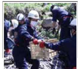
がれき等の撤去作業 （西原村消防団）
