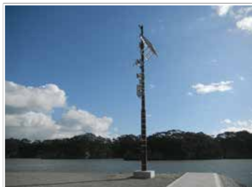
津波監視カメラ
