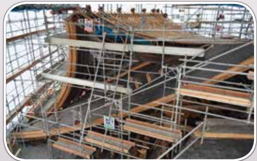
補修工事中の阿蘇神社
