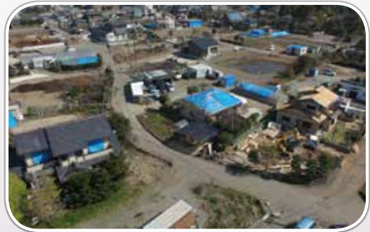
損壊したままの建物が残り、更地も目立つ(益城町)
