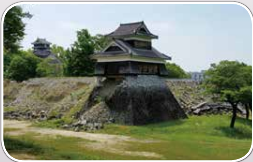
まだ、これからの補修の熊本城の外丸
