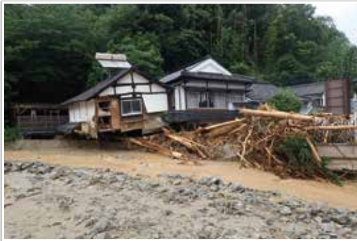
家屋被害と流木（福岡県朝倉市）
