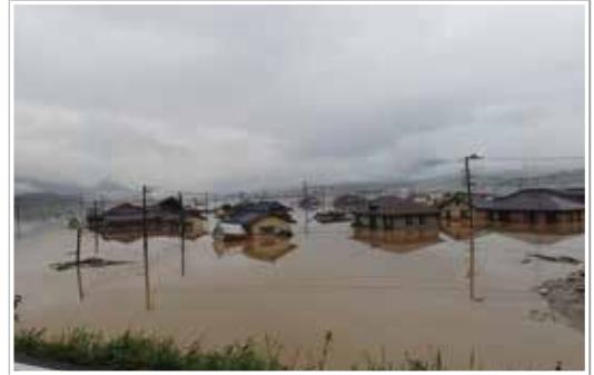
岡山県倉敷市真備町（浸水現場）
