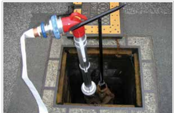
写真2 消火栓の水圧を利用するスタンドパイプ (普及が広がる今注目の地域の消火用具)
