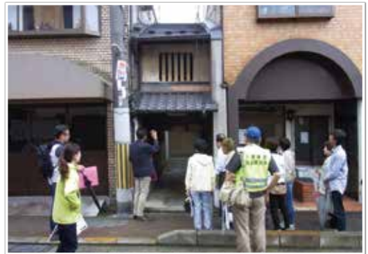
トンネル路地の耐震化
