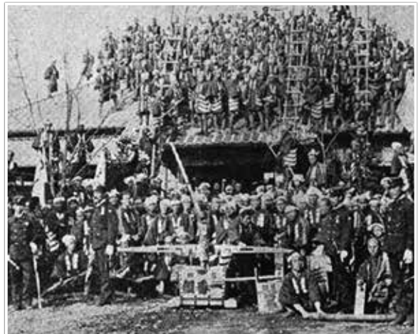
第4消防分署（現在の本郷消防署）の「龍吐水」（明治初期）
