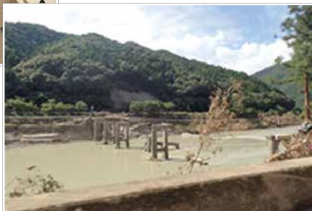
写真2 球磨川の氾濫流による橋梁の破損状況
