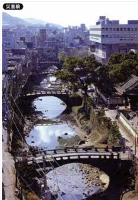
写真2 中島川に架かる石橋群（提供：長崎県土木部） 3)
