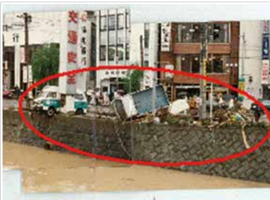
写真5 被災後の放置車両の状況 (提供;長崎県土木部)
