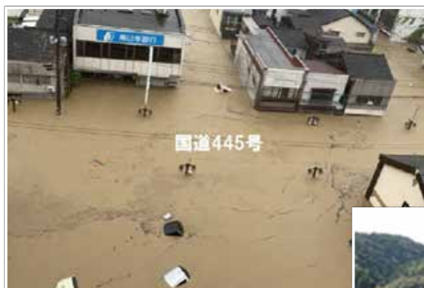
写真1 熊本県人吉市内国道445号の浸水状況
