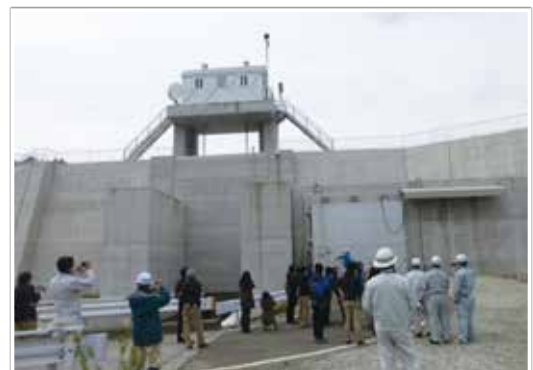
自動閉鎖システムを整備した防潮堤の陸閘 （大船渡市 合足（あたり）海岸）
