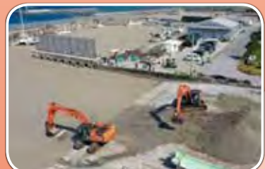
漂着した軽石の除去作業
