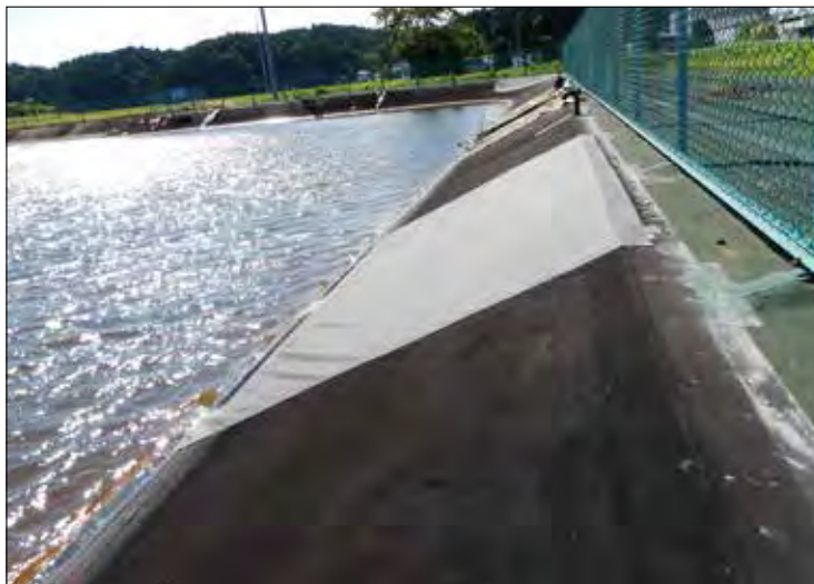
図1 典型的なため池、ゴムの遮水シートが斜面に張ってある
