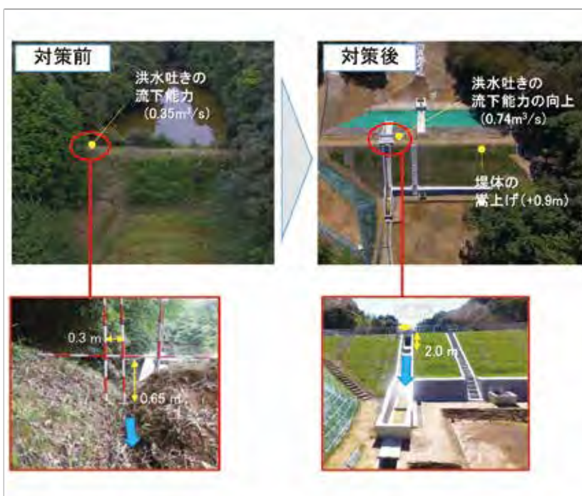
写真2 防災工事の状況
