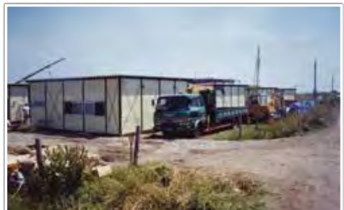
急ぎよ整備が進められた被災者のための 応急仮設住宅(青苗地区)
