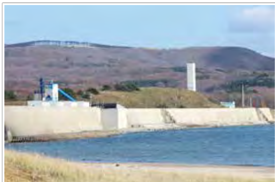
青苗漁港から見た防潮堤
