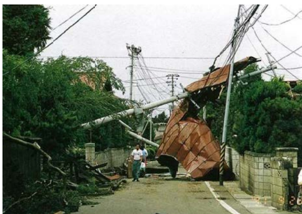
屋根トタン飛散による電柱倒壊（平川市(旧平賀町)）
