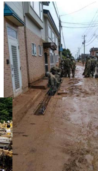
自衛隊による側溝の泥上げ
