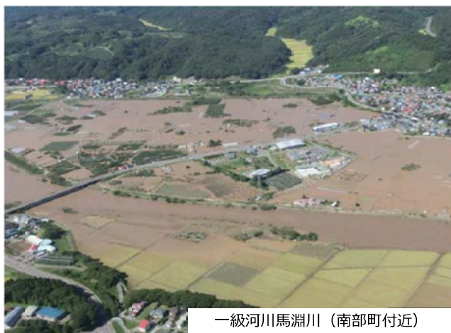
一級河川岩木川（つがる市付近）
