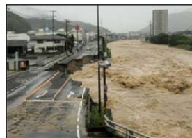
国道2号被災広島県広島市安芸区中野東
