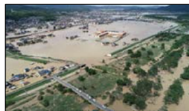
小田川堤防決壊岡山県倉敷市真備町
