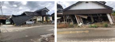
珠洲市見附海岸周辺 家屋(倒壊)
