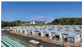
応急仮設住宅@穴水陸上競技場
