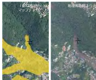
2021年7月の熱海市土石流の災害後の空中写真(右)と、災害前の空中写真に2023年7月現在の土砂災害警戒区域を重ねた図(左)。集落より上流側の土石流が流下した場所は土砂災害警戒区域となっていないが、土石流危険渓流となっていた。
