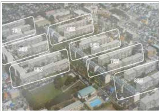
【写真1】相武台グリーンパーク全景
