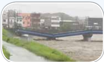
静岡県沼津市と清水町を結ぶ「黄瀬川大橋」
