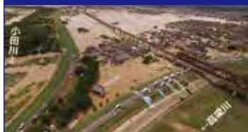
⑤小田川における浸水被害 (岡山県倉敷市)
