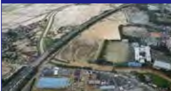
④桂川における浸水被害 (福岡県朝倉市)
