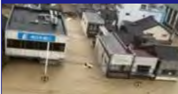
⑨球磨川における浸水被害 (熊本県人吉市)
