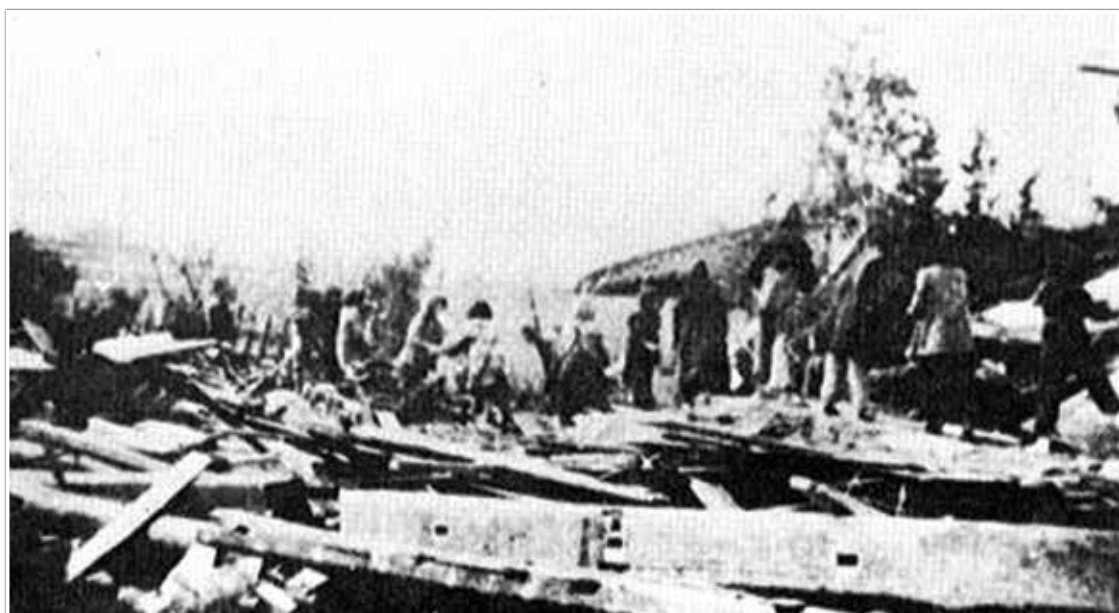
三河地震による家屋の倒壊
