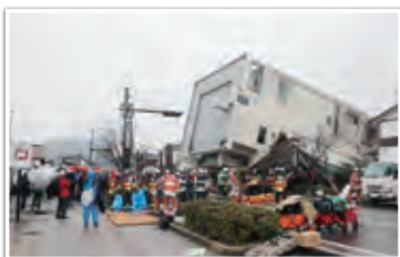
輪島市河井町建物倒壊現場（大阪市消防局提供）
