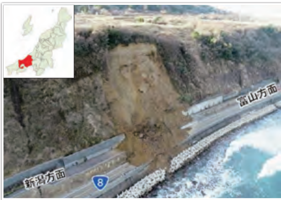
国道8号 土砂崩落状況 (上越市大字茶屋ヶ原地先)
