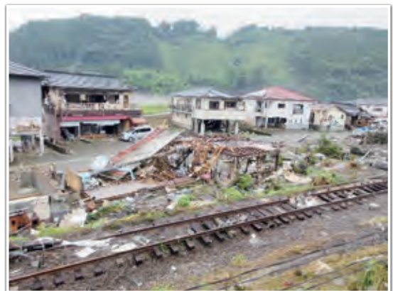
写真1 球磨川の氾濫流による家屋等の破壊・流失 （熊本県球磨村渡地区）
