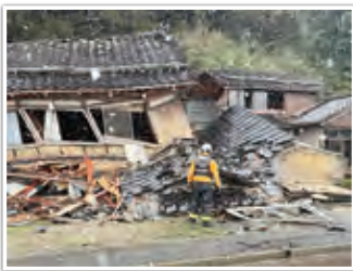
珠洲市正院町家屋倒壊現場
