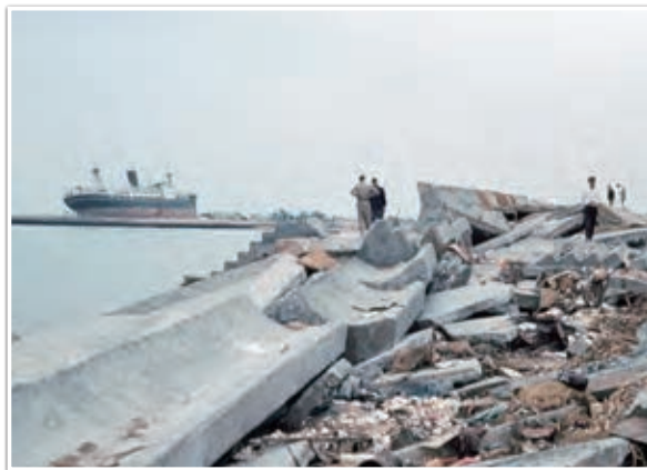
写真2 1959年伊勢湾台風による高潮と高波による護岸の決壊と大型貨物船の漂流（わが国で初めての被災地のカラー写真）
