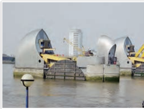
写真3 テムズ川に設けられた回転型高潮水門でロンドンを守っている。
