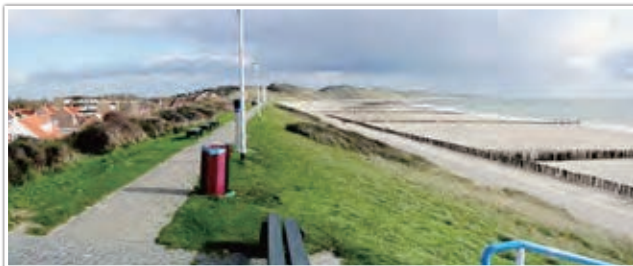
写真4 オランダの高潮堤防。1万年に1回発生する巨大高潮に耐えられるように2000年に完成した。
