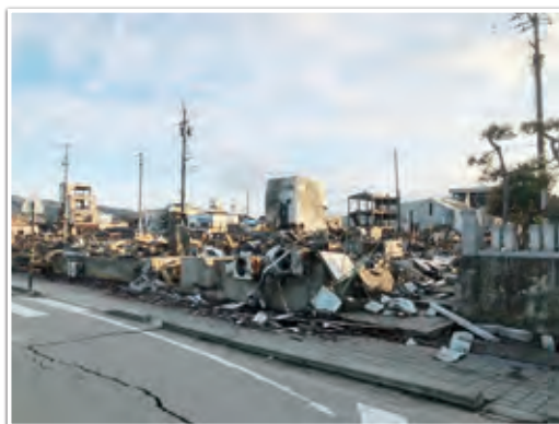
朝市周辺火災（鎮火後）
