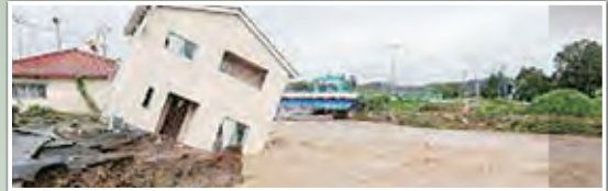
石川県珠洲市(大雨：令和6年9月22日(日))
