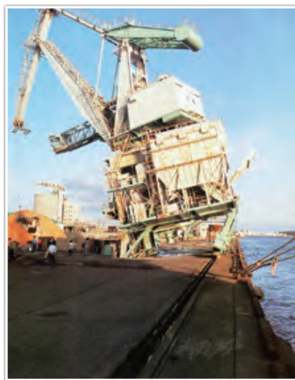
秋田港の荷揚げ施設の被害状況
