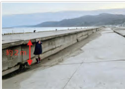
岸壁背後の沈下（輪島港）
