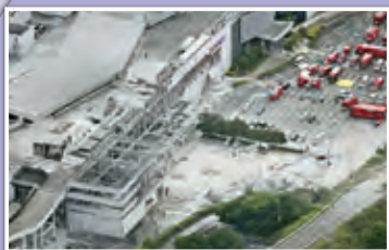
大きな被害がでたイオンモール熊本 (熊本県嘉島町)
