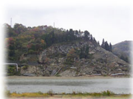
現在の妙見堰近くの崩落現場の様子
